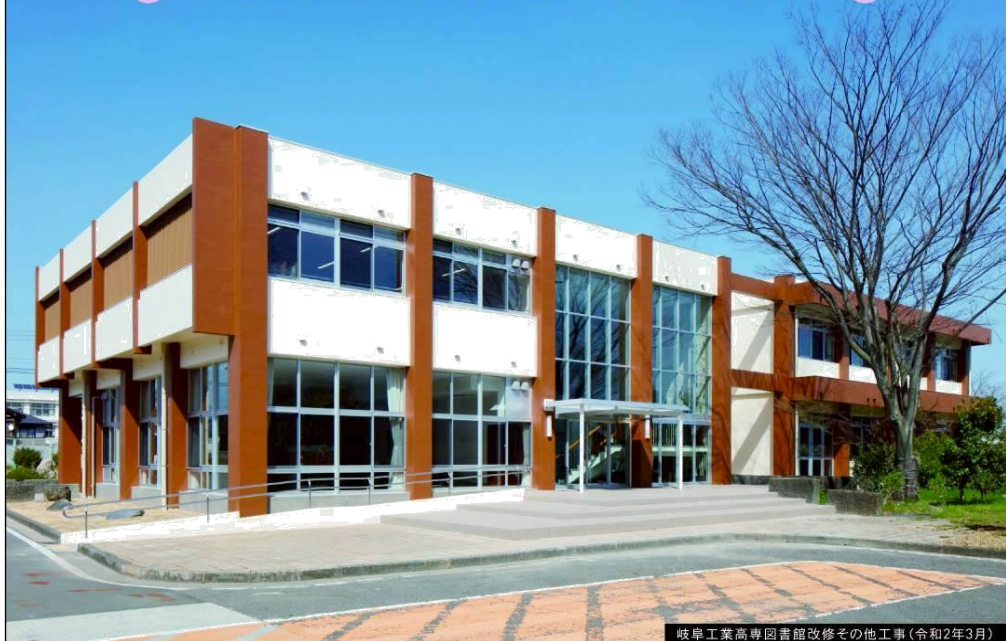
岐阜工業高専図書館改修その他工事(令和2年3月)
